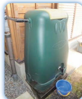
雨水貯留タンク設置例
